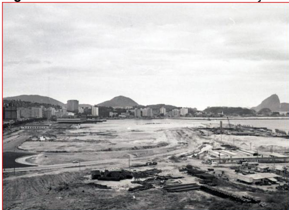
Figura 5. Aterro da Praia Grande em execução.
